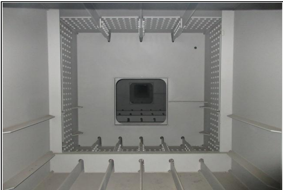
강박스 내부 전경
