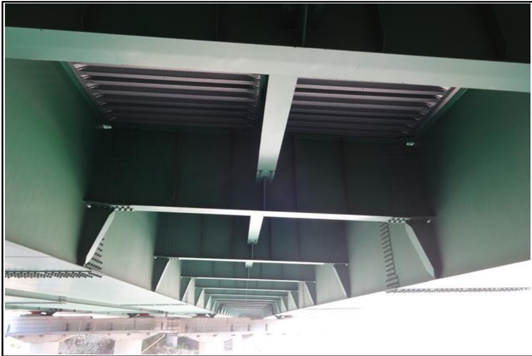
바닥판하면 및 거더 외부 전경
